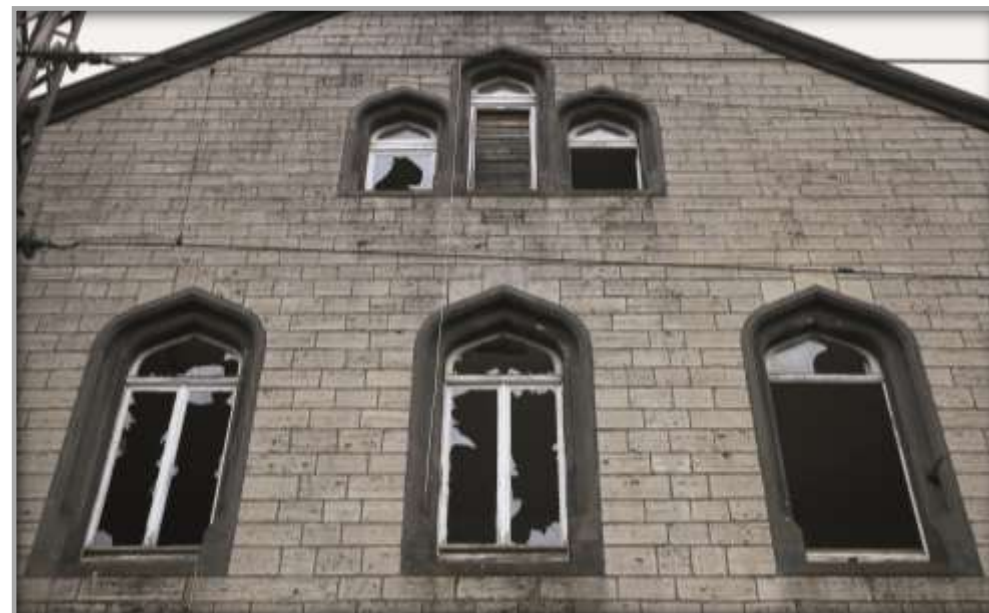
Außenansicht vor der Sanierung (Gleisseite)
