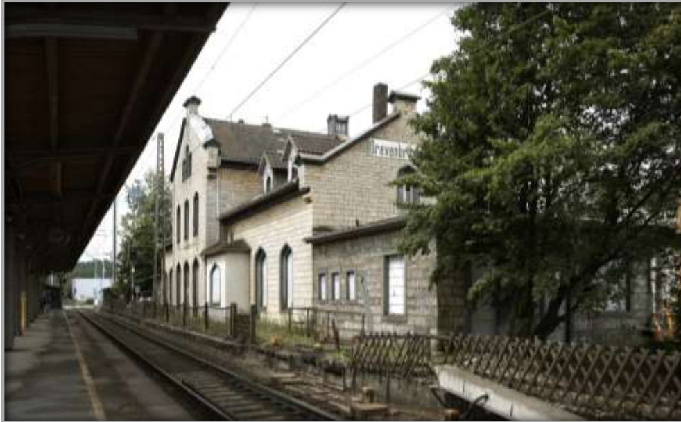
Empfangsgebäude und Bahnsteiganlage vor der Modernisierung
