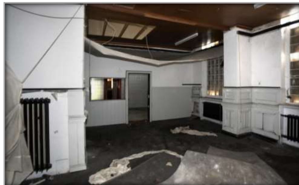
Innenbereich vor der Sanierung
