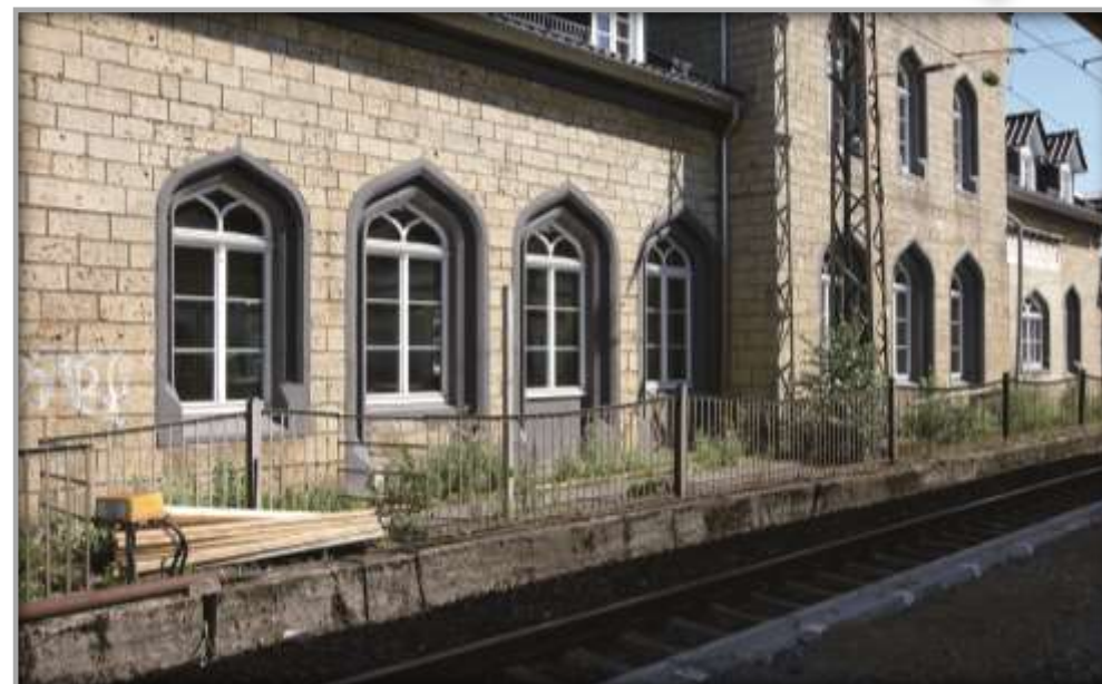
Außenansicht nach der Sanierung (Gleisseite)
